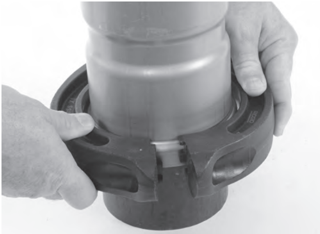
Figura 11 – Colocación del aro sellador en el acoplamiento
