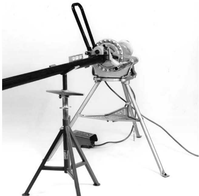
Figure 7 – Nivellement du tuyau.
