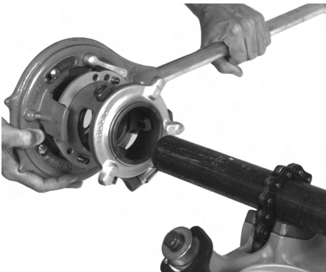
Figure 5 – Enfilage de la fileteuse sur le tuyau
