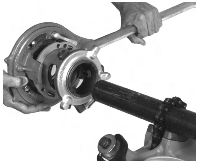
Figure 5 – Montaje de la Roscadora en el tubo
