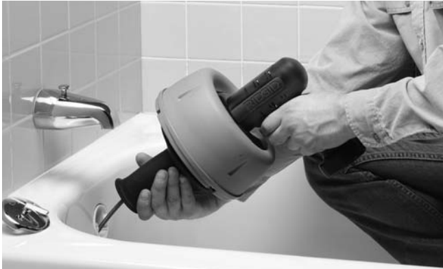
Figure 6 – Poussez le câble le long de l'évacuation
