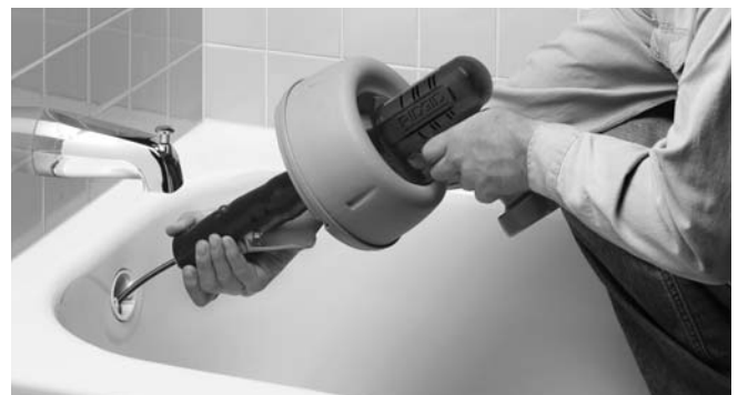
Figure 8 – Tenez le dégorgeoir à un maximum de 6 po du point d'entrée
