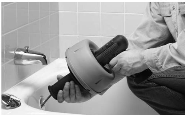
Figura 6 – Empuje cable por el desagüe
